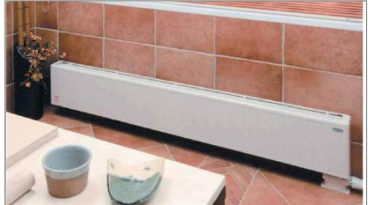
ふく射熱が空間を通して、やさしく体を温めるパネルヒーター。窓下に設置すれば、窓からの冷気を和らげ結露を防ぎます。
