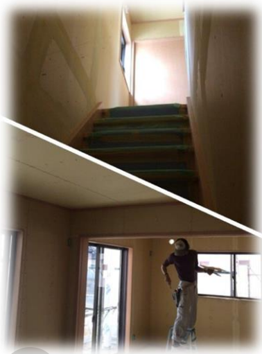
クロス工事までできました。 あともう少して、新築工事が完成です！
