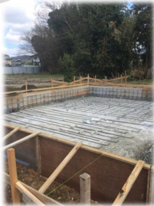
新たな新築工事が始まりました。 基礎の工事をしています。
