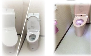
トイレ取替工事。 現在のトイレは昔のトイレに比べ、水量も半分くらいになり水道代がおトクです。
