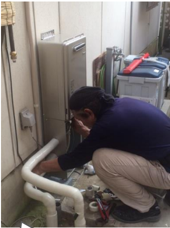
石油給湯器から ガス給湯器に交換しました。
