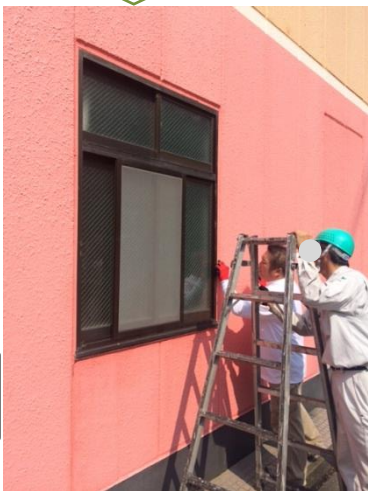
外壁塗装のやり替え。 これで大雨でも安心。
