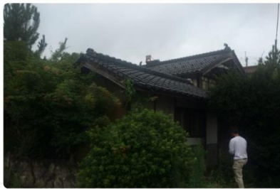
解体工事が始まりま した。意外と広い！
