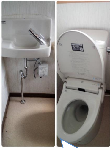
自動洗浄トイレ センサー付き手洗い器 に交換しました。
