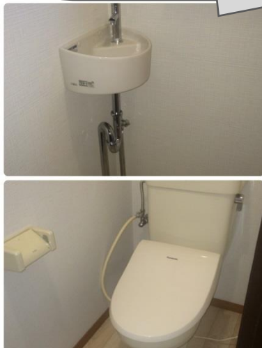
トイレリフォーム。 床も壁もやりかえて、手洗い器 もつけました。
