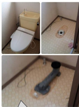
古いトイレを新しく。 床工事なしでも出来ます。
