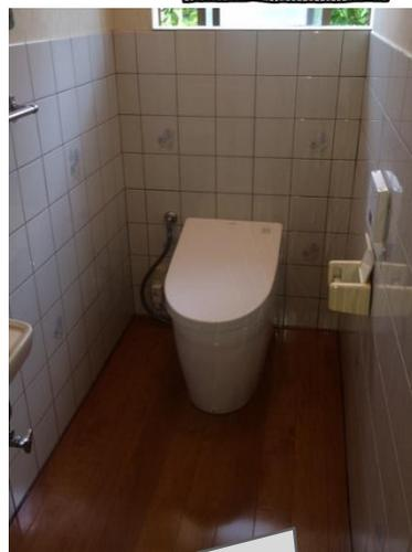
旧式のタンク式トイレを最新のタンクレストイレに。超節水で便座自動開閉とオート洗浄機能もついています。
